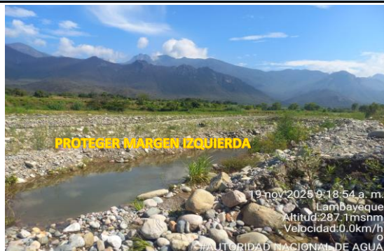
FIGURA N°01 Y 02: ESTADO ACTUAL DE LOS TERRENOS AGRICOLAS (SECTOR CANAL FIRRUÑAF), SE APRECIA EL DAÑO CAUSADO POR EL RIO LA LECHE, CAUCE TOTALMENTE COLMATADO, CAS NIVEL DE TERRENOS AGRICOLAS, PONIENDO EN RIESGO AL CANAL FIRRUÑAF
